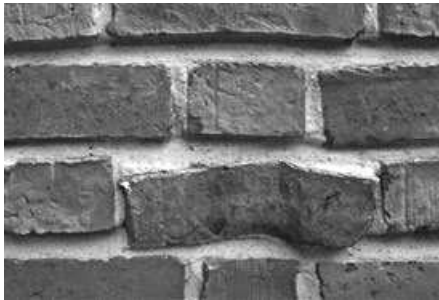
Fotografie di dettagli costruttivi.
